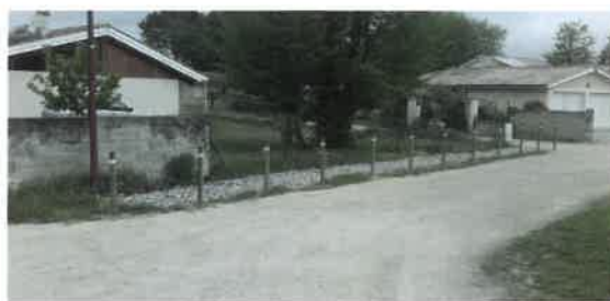
Photo 1 : sécurisation du carrefour de Darriet
