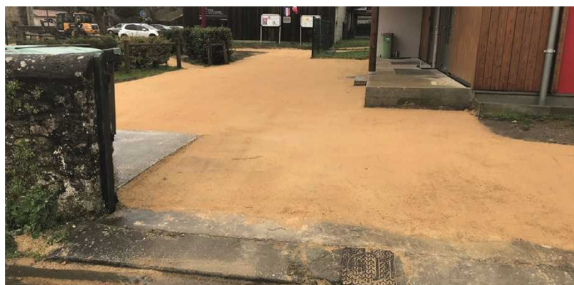
Le quai de déchargement terminé.
