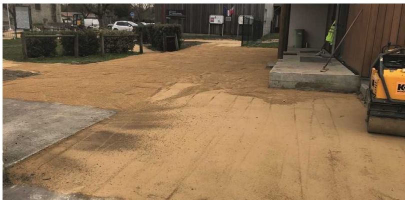
Le quai de déchargement en cours de travaux
