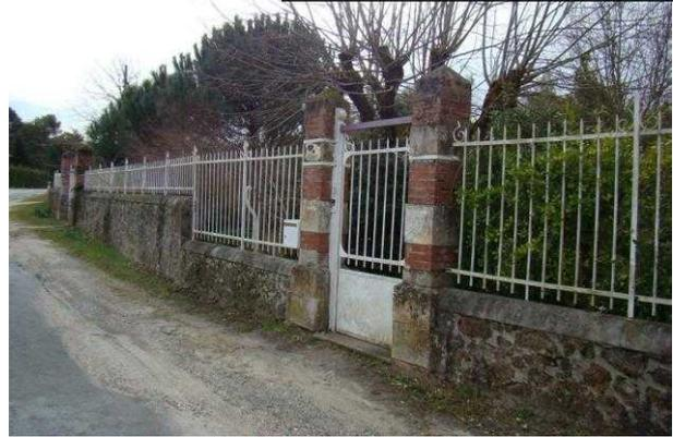
Mur de clôture constitué d'un mur bahut surmonté d'une grille.
